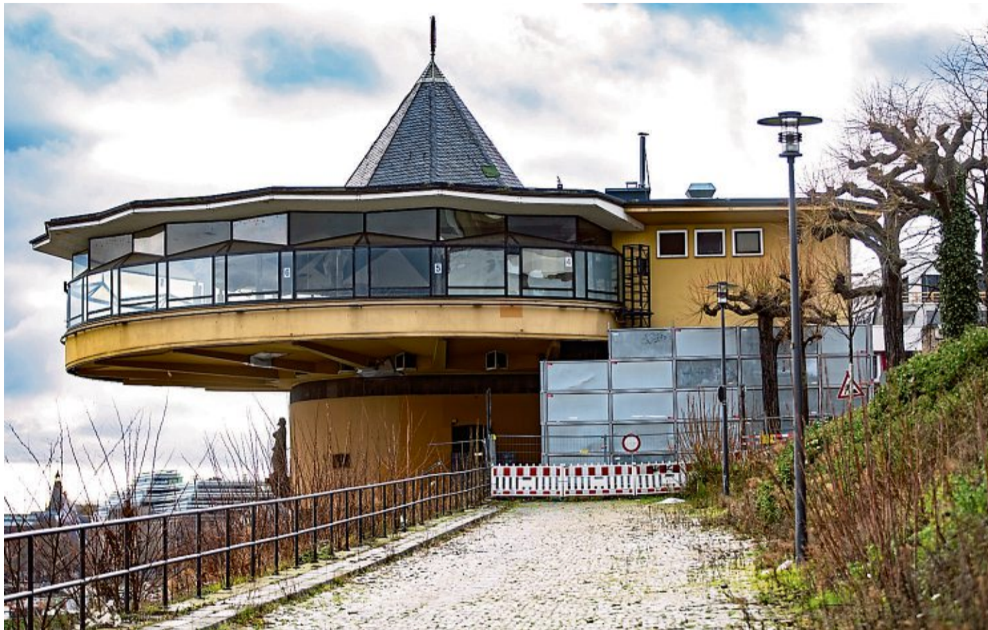
Die Bastei muss gestützt werden. Doch das Gerüst versperrt den Weg zu Rampe hinunter zum Rheinufer.
